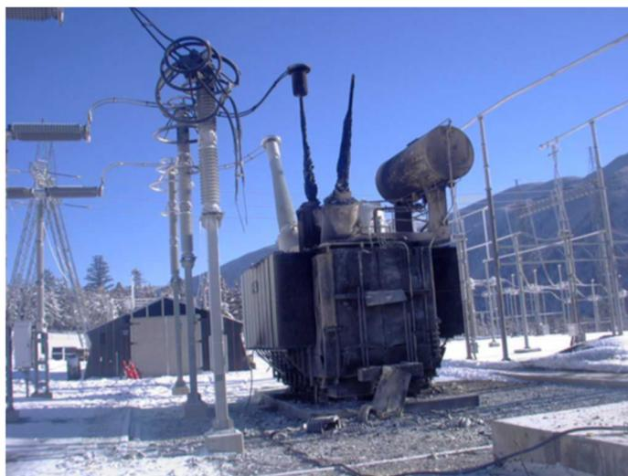
**Рис. 2. Нештатная ситуация на подстанции в северной части Канады – повреждение высоковольтных вводов вследствие развития частичных разрядов**
