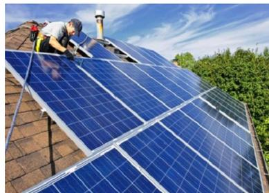
**Рис. 8. Микрогенерация, монтаж СЭС-установки**
