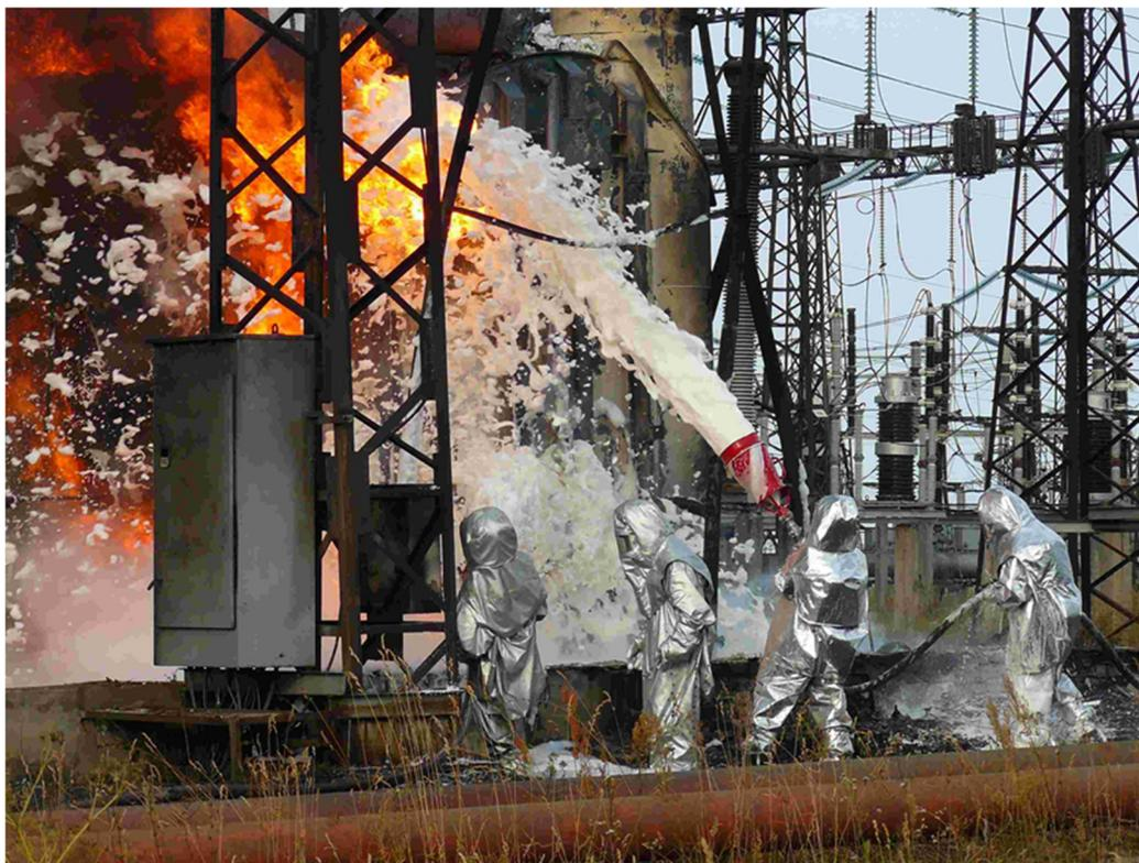
**Рис. 5. Тушение горящих на подстанции 500 кВ автотрансформаторов, повредившихся вследствие отказа защит и КЗ на шинном мосте 10 кВ**
