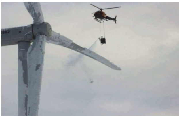
Рис. 2. Обледенение лопастей ветроэлектрических станций
